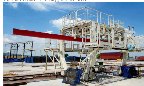
Carri di servizio - Montaggio in cantiere
