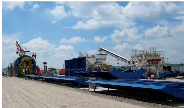
Carri di servizio - Montaggio in cantiere
