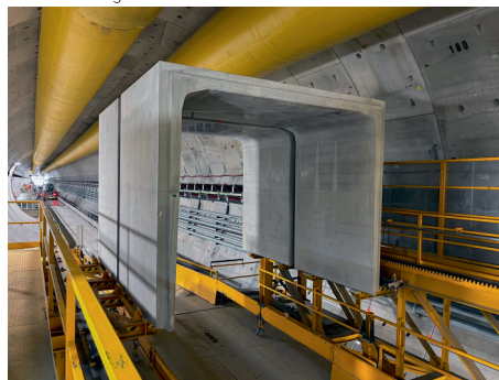
Tunnel di servizio installato
