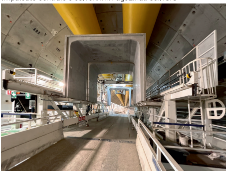
Impalcato centrale e culvert immagazzinati sull'ISIG
