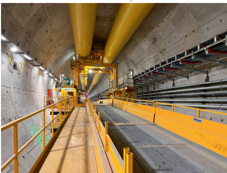
Impalcato centrale e culvert immagazzinati sull'ISIG
